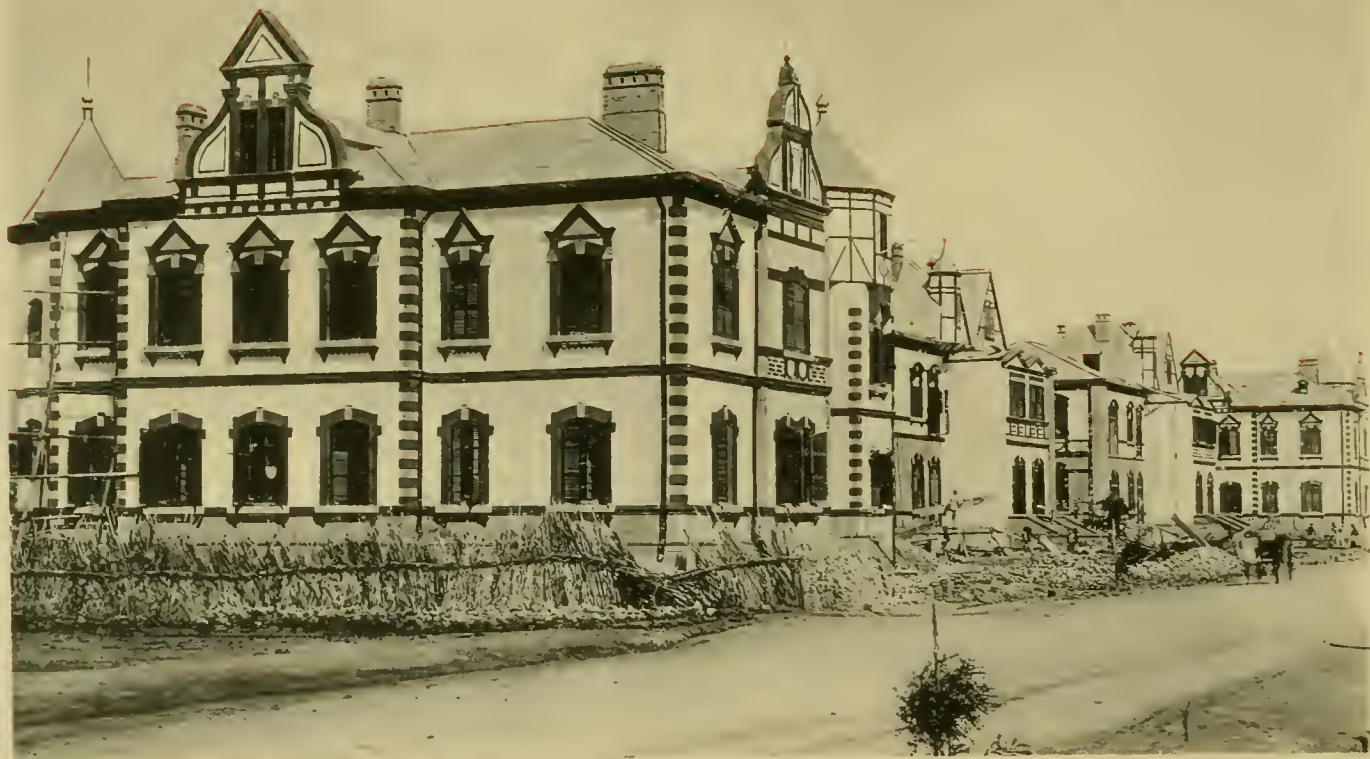
Tientsin. Die neuen Offizierhäuser in der Wilhelmstrasse im Bau
